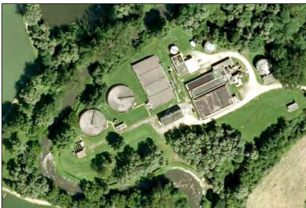
Figura 17 - depuratore di Gaggio
