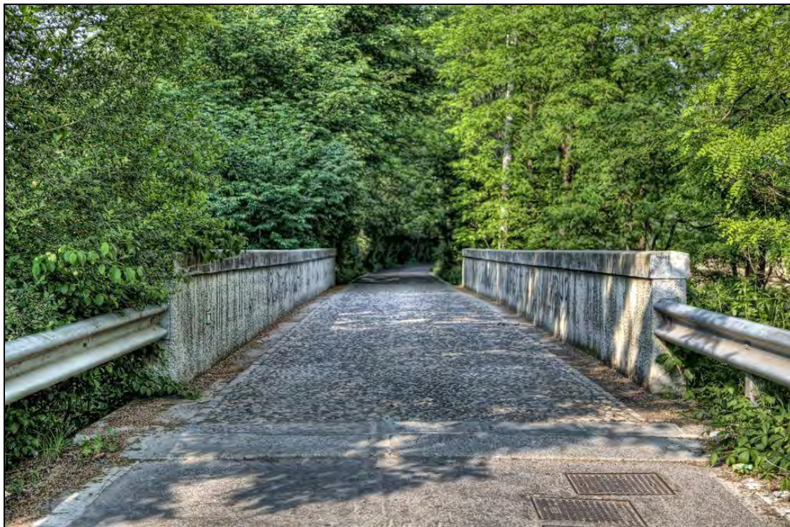
Figura 7 - ponte di Fornacetta
