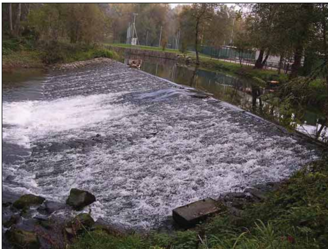
Figura 51 – Vista di valle della traversa sul Lambro
