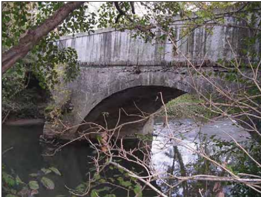
Figura 30 – Vista da monte del secondo ponte zona Fornacetta
