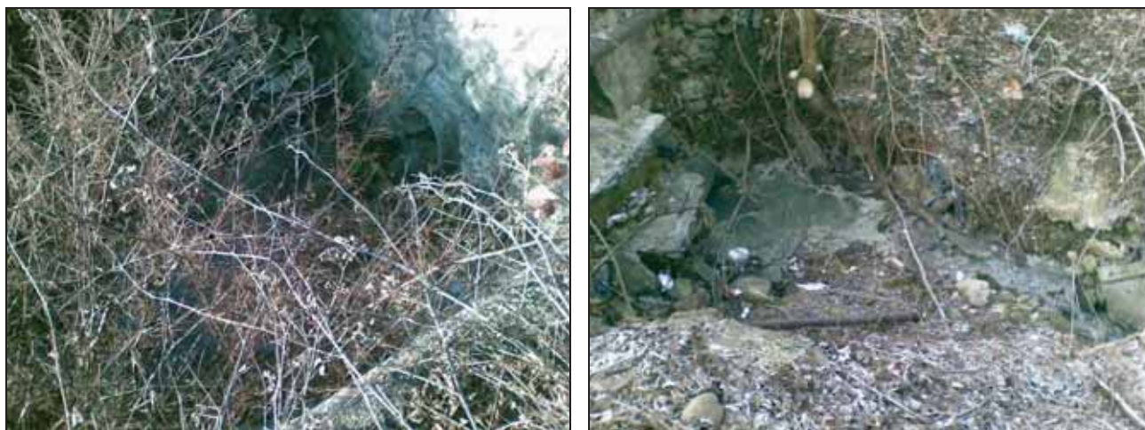
Figure 31 e 32 – I due manufatti fognari all'imbocco dei rami occidentali della Roggia di Romanò
