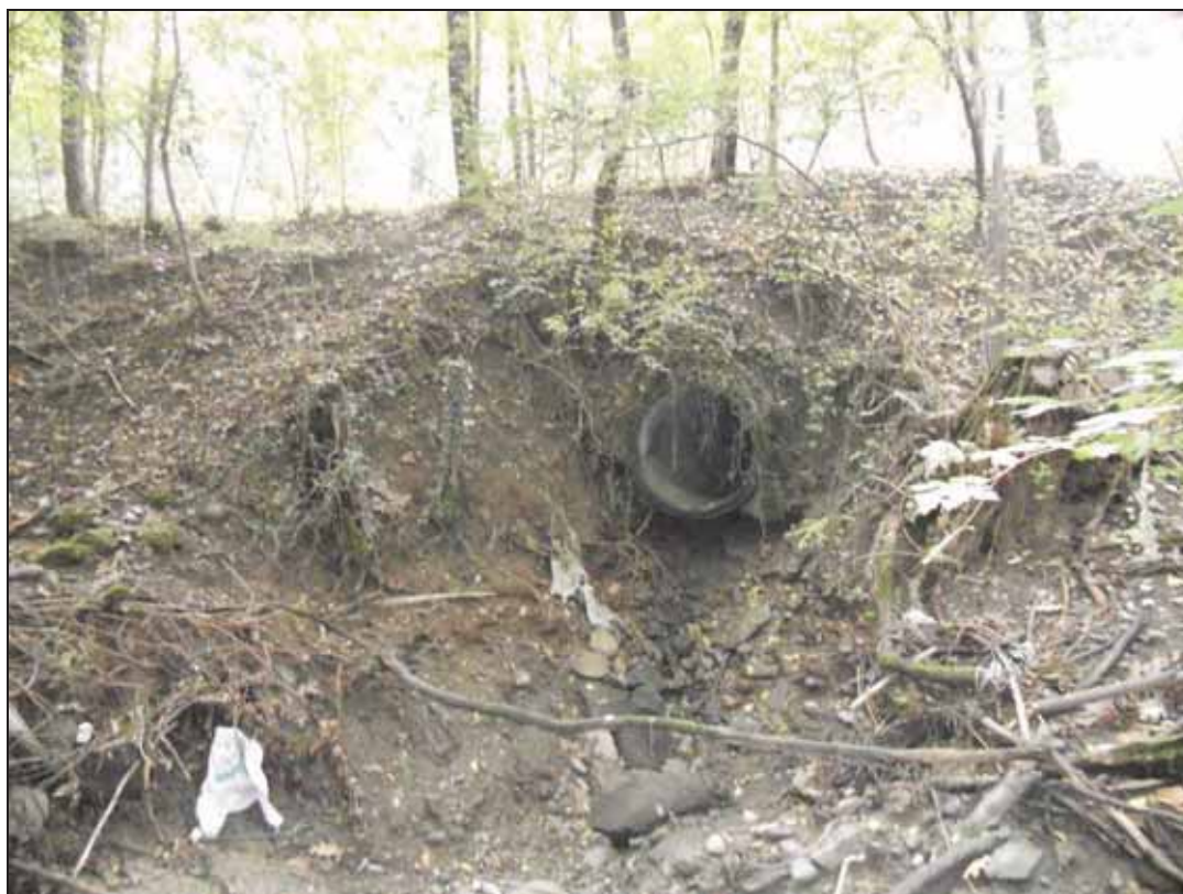
Figura 33 – Sfioratore fognario sull’Orrido
