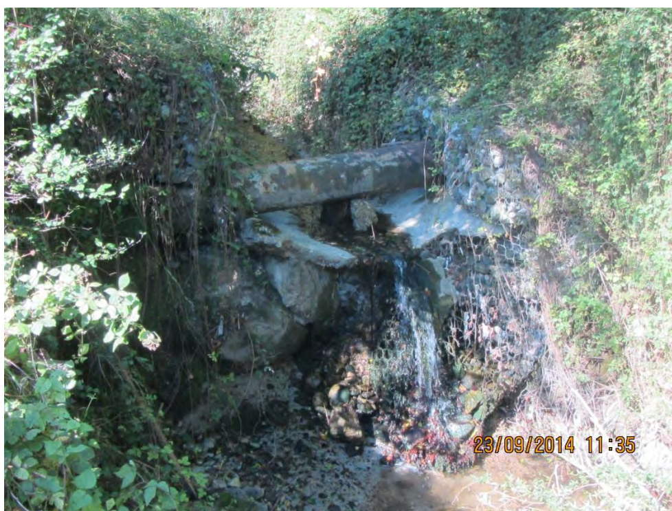
Attraversamento della tubazione smaltimento delle acque urbane, gabbionate danneggiate e salto di fondo
