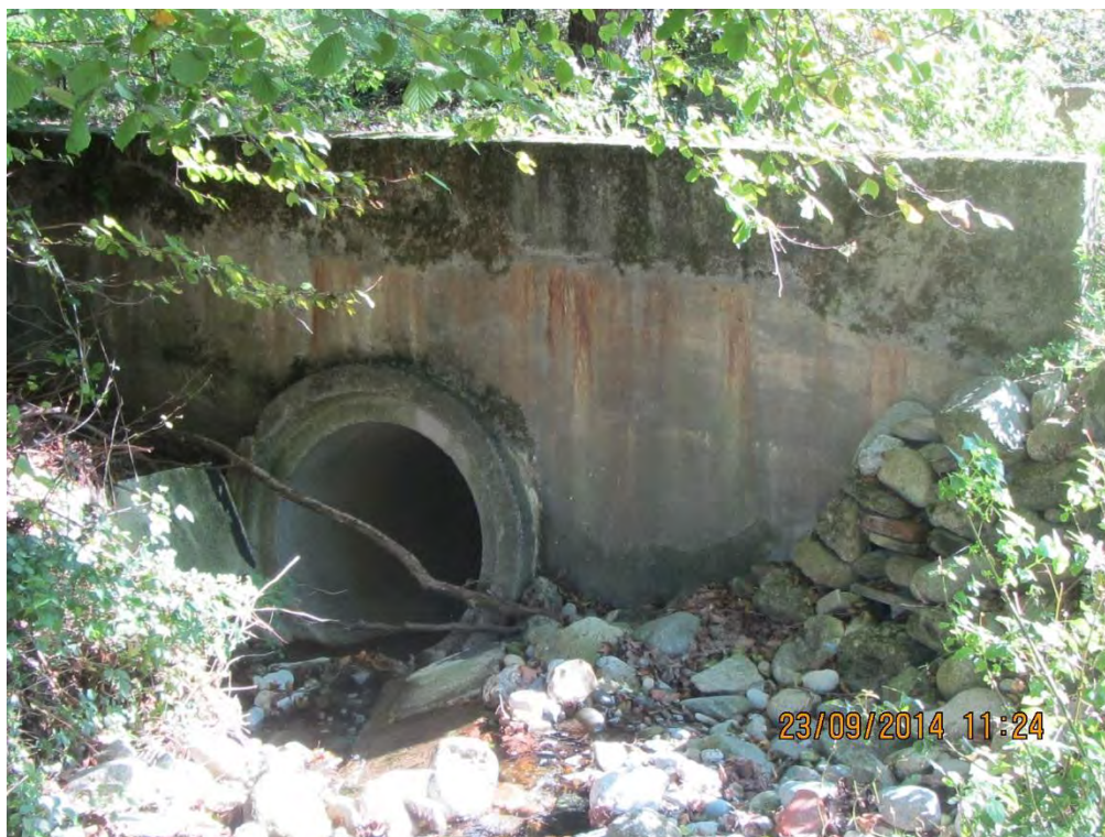
Attraversamento di accesso all'area erbosa racchiusa tra le due rogge, tubazione in calcestruzzo di diametro 1.0 m
