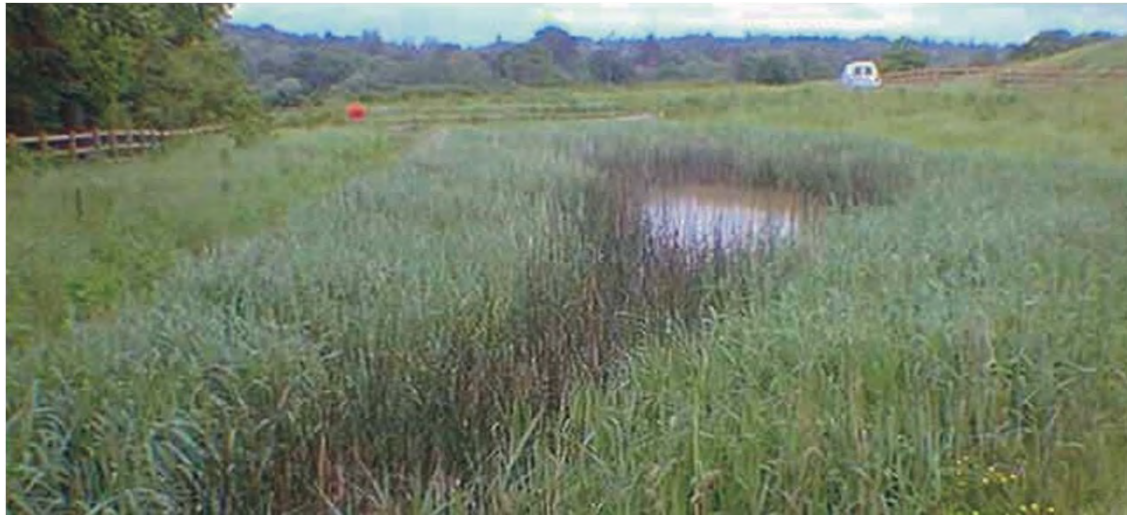
Sistema di depurazione naturale a flusso libero per il trattamento delle acque di dilavamento di un'autostrada (UK)
