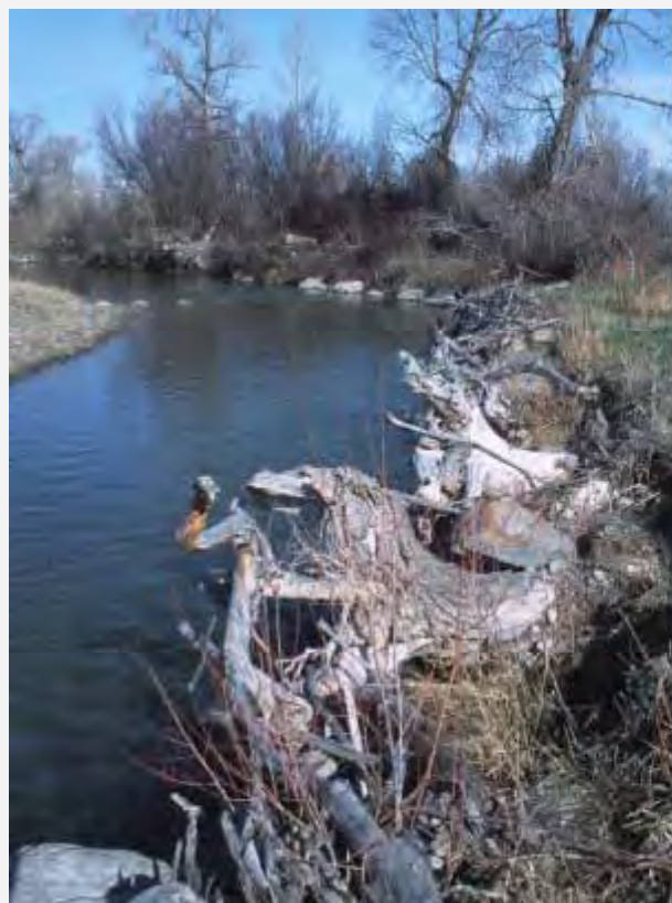
DIFESE SPONDALE CON RADICI (A SINISTRA), CON RADICI E RAMAGLIA (IN ALTO A DESTRA) E CON TRONCHI (IN BASSO A DESTRA)
