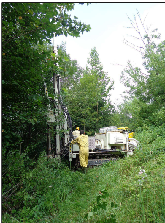
esecuzione sondaggio S2
