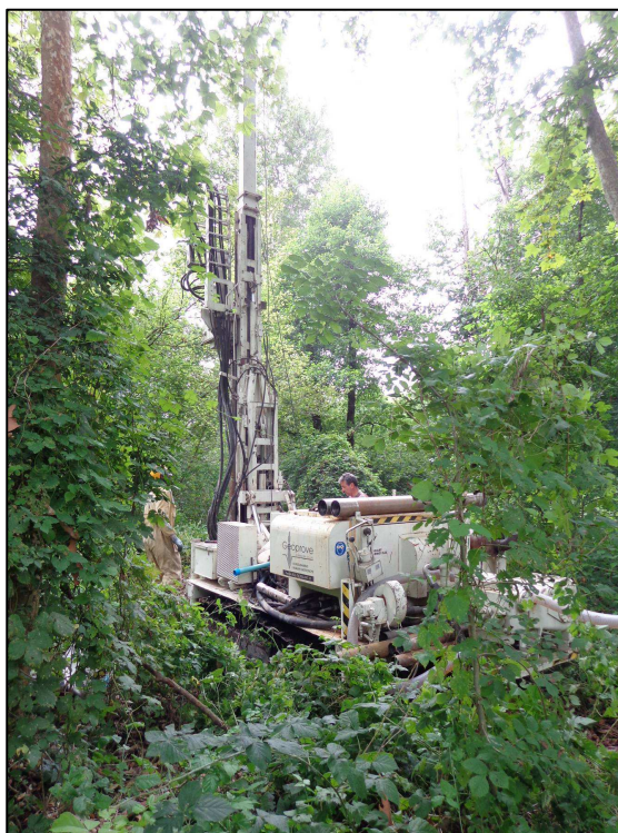
esecuzione sondaggio S4
