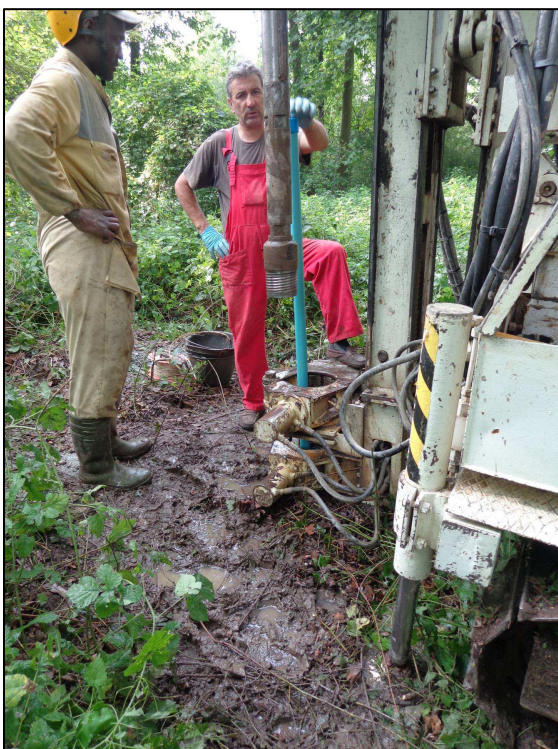
posa tubo piezometrico
