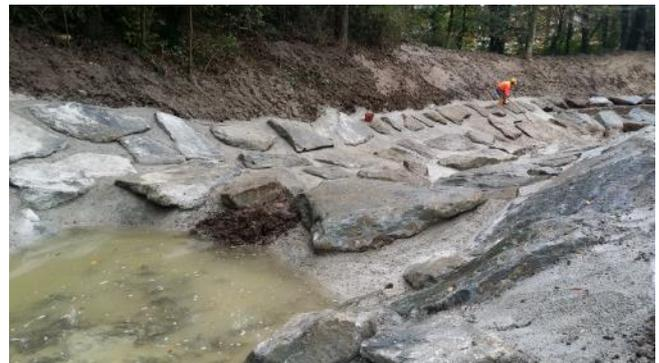
Figure 8: Primo bacino di calma e seconda rampa per la risalita dei pesci (13 ottobre 2016)
