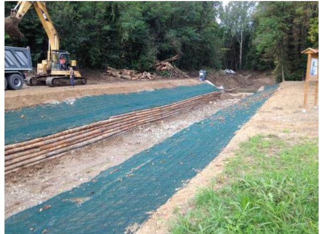
Figure 7: Rampa per la risalita dei pesci nel primo tratto e mascheramento muretti di sponda nell'ultimo tratto con posa di georete (06 ottobre 2016)
