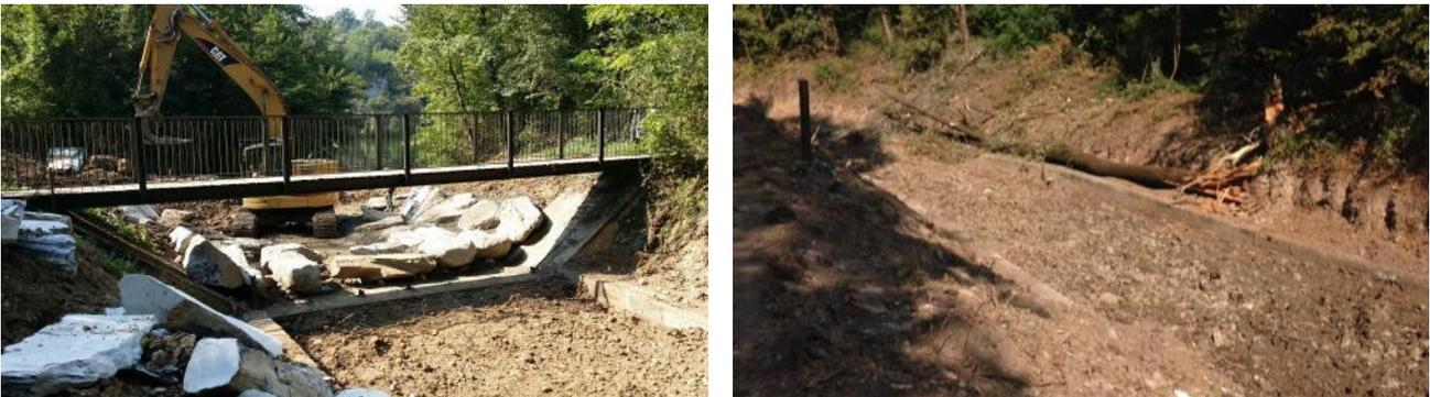
Figure 4: Mascheramento soglia ad incile lago e riprofilatura del fondo alveo (8 settembre 2016)
